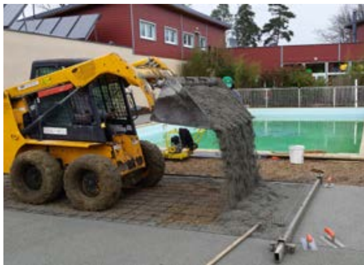
Mise en place du béton drainant
